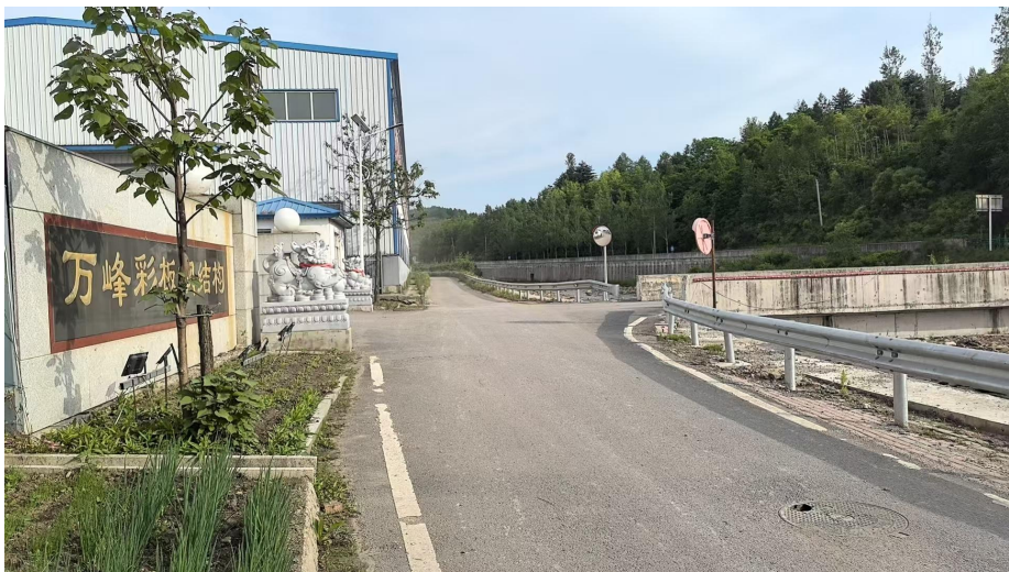
西侧隔村路为石人河
