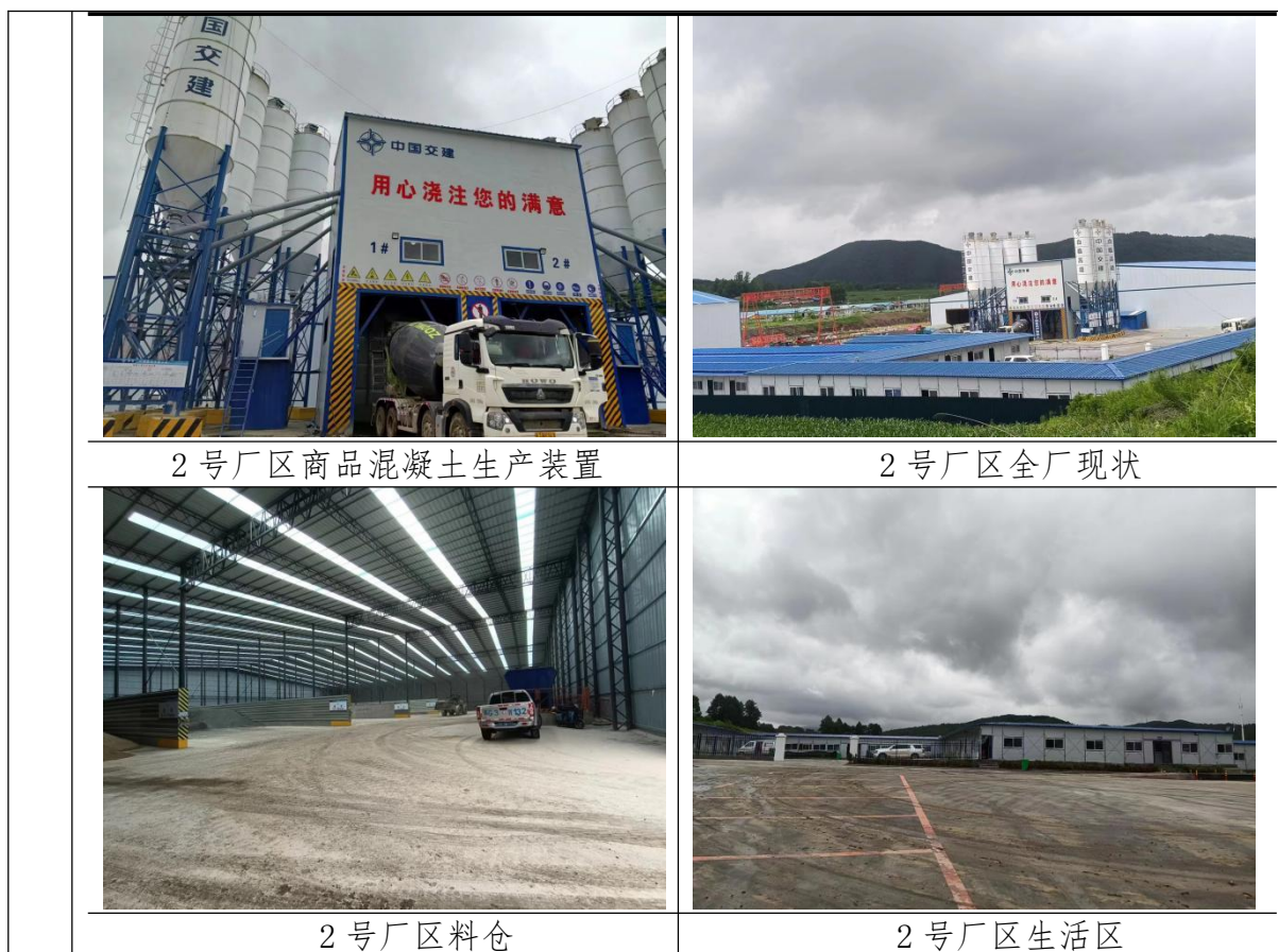
图1 本项目厂区内建设情况
